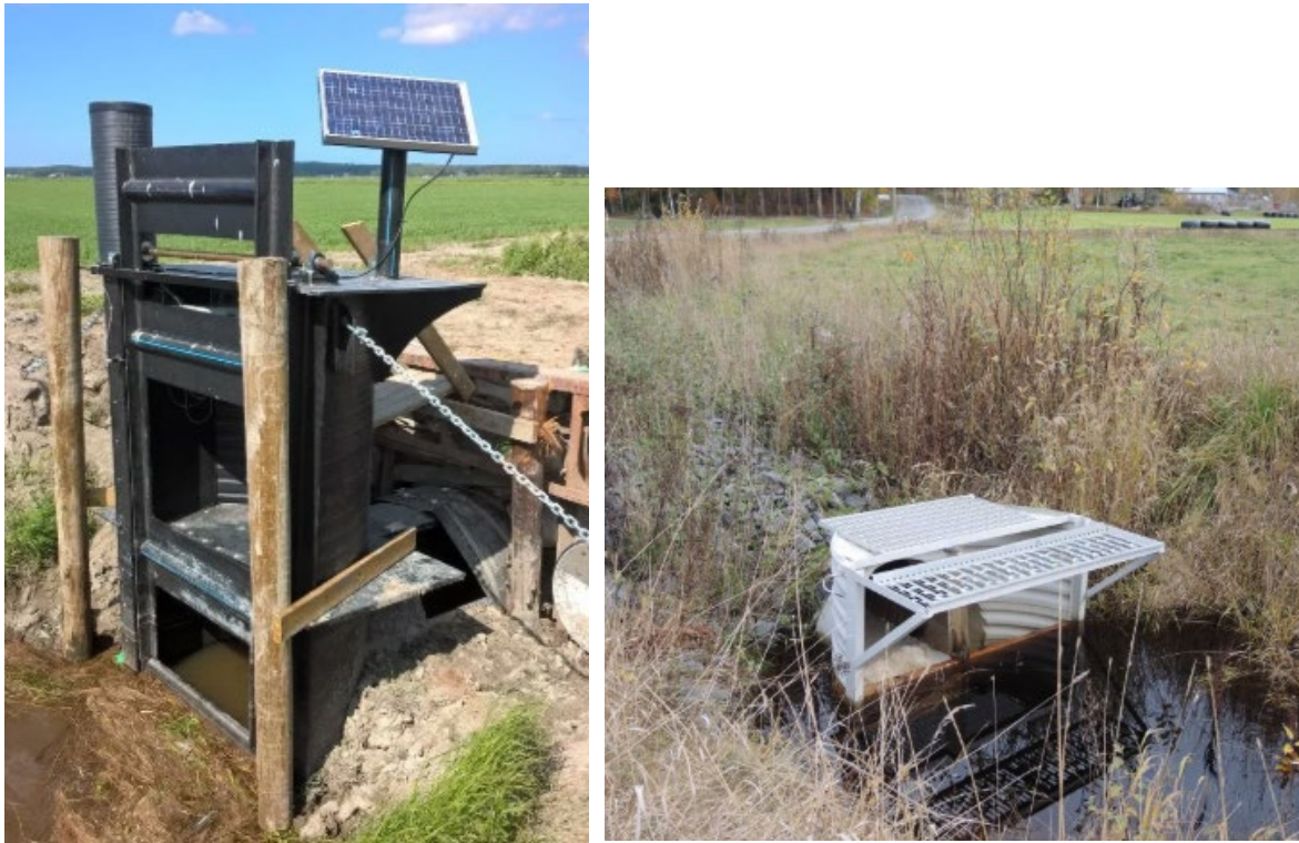
Kuva 5. Esimerkkikuva kahdesta eri tavalla toteutetusta säätöpadosta, metallirakenteinen ja muovipato.
