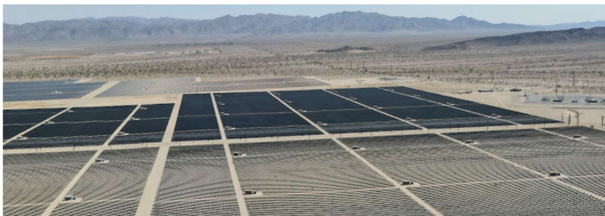
Kuva 7. Desert Sunlight aurinkovoimalaitos Kaliforniassa kuva: Jake Tolison.
