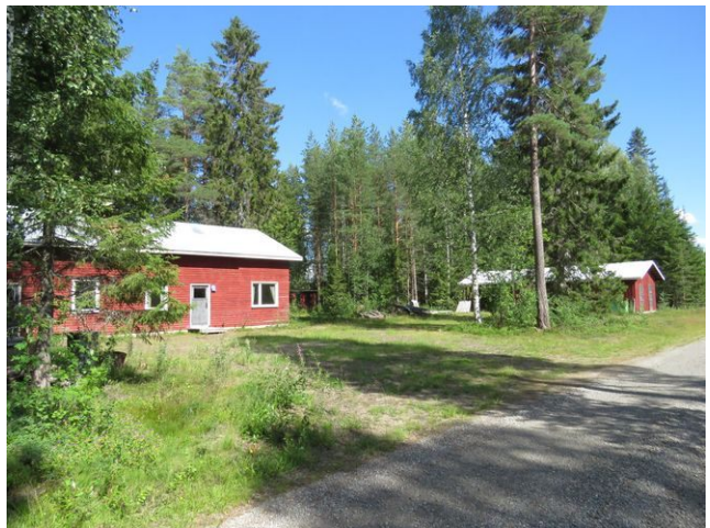
Kuva 16. Metsästysmaja Kettusenkaalla; koilliseen.
