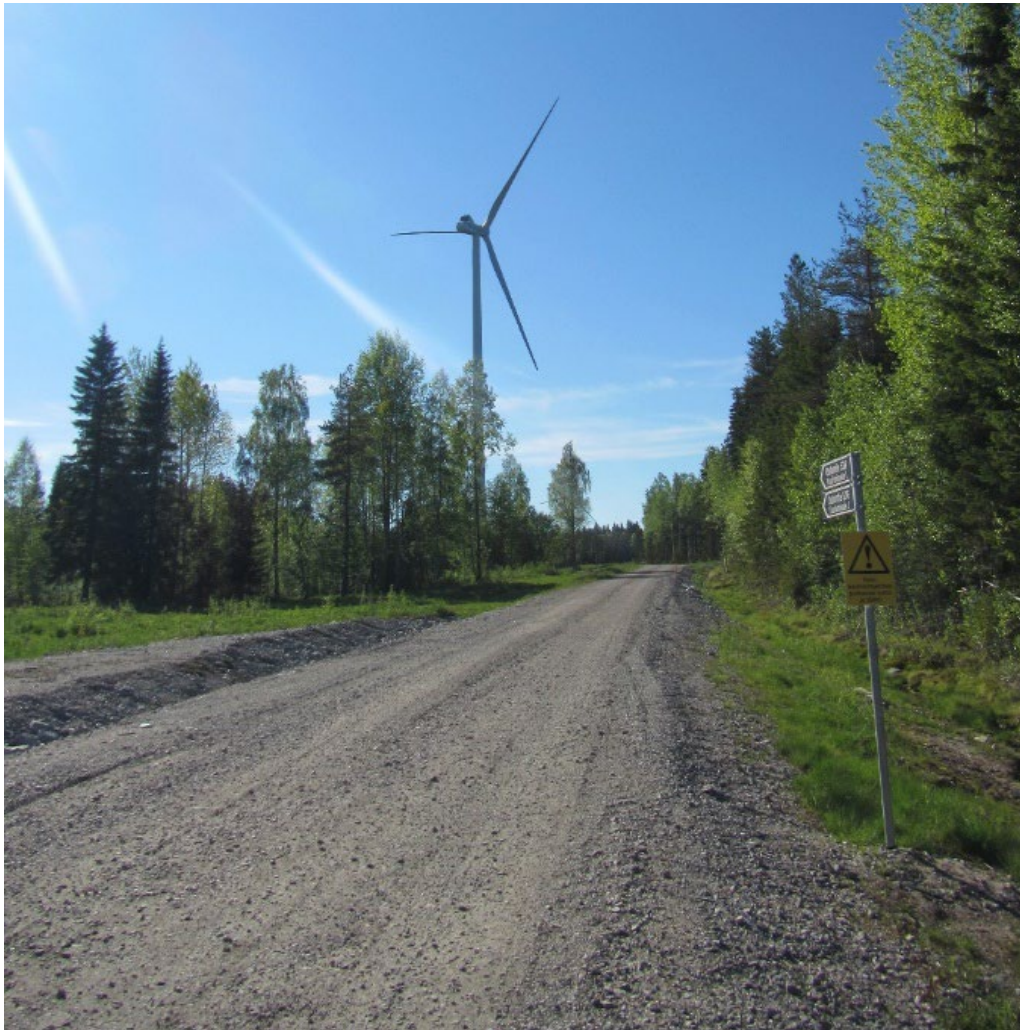
Kuva 4-5. Esimerkki tuulivoimapuiston rakennus- ja huoltotiestä. © AFRY Finland Oy.
