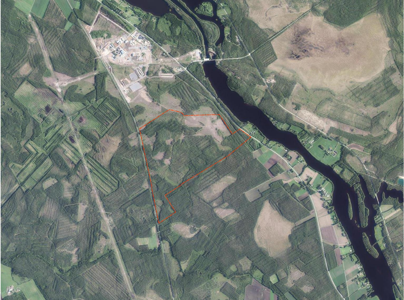
Ilmakuva alueelta ja suunnittelualueen alustava rajaus. (Ortokuva Maanmittauslaitos / Paikkatietoikkuna).
