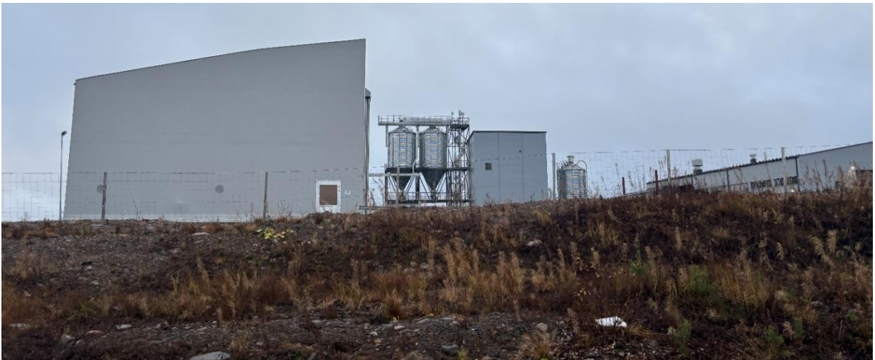
GRK:n biohiililaitos sijaitsee noin 500 m etäisyydellä asemakaavan laajennusalueesta pohjoiseen.
