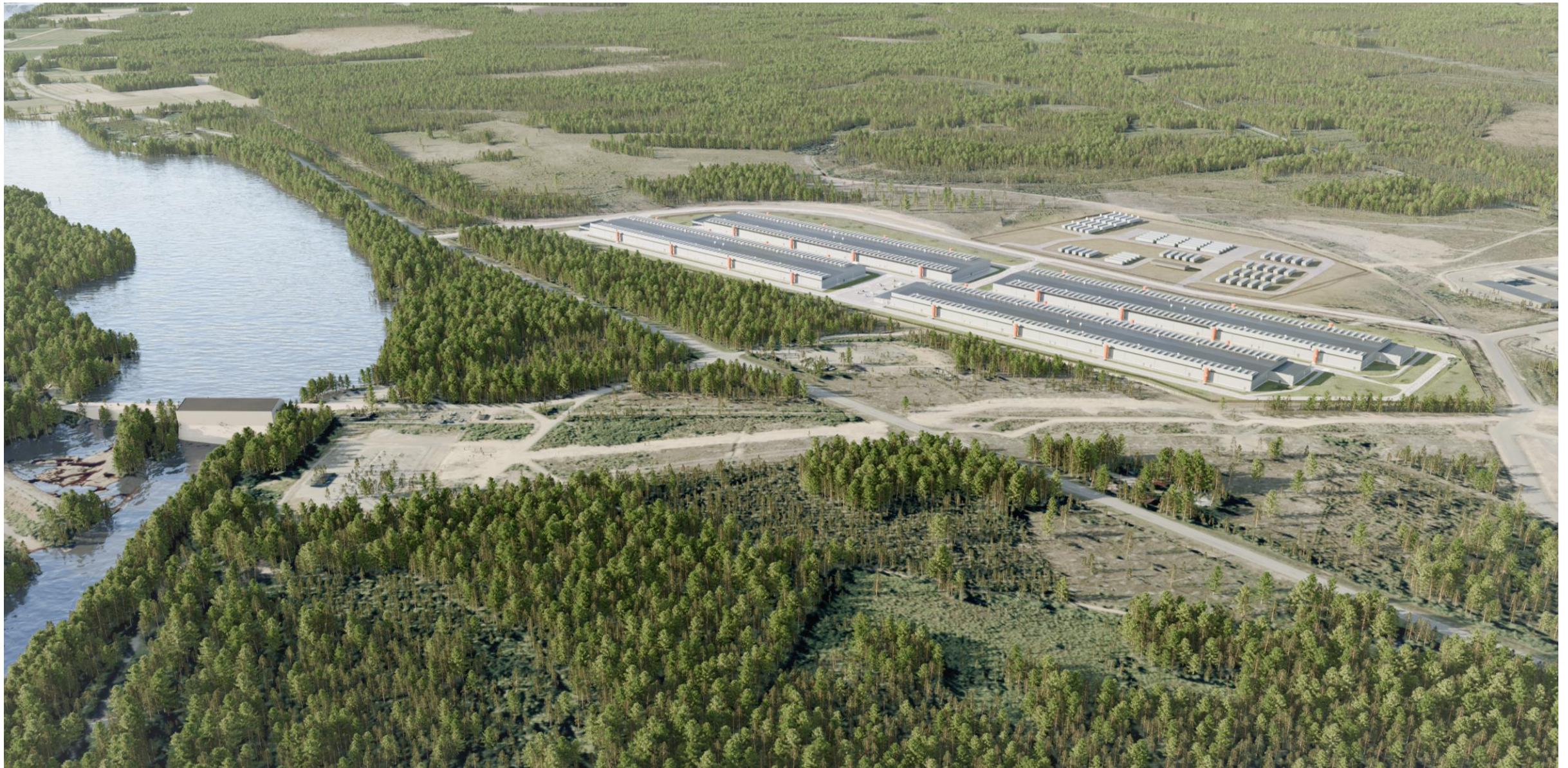
Kuva 2. Datakeskusalue pohjoisesta. Vasemmalla Utasen voimalaitos.
