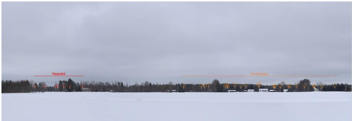
Kuva 10-25. Yhteishavainnekuva ja "rautalankamalli" Maaselän ja Tornikankaan tuulivoimaloista. Voimalat on tuotu valokuvan päälle niiden sijainnin havainnollistamiseksi. Kuvauspaikka (nro 5) on Utajärven Ala-Niskassa, Kajaanintien (valtatie 22) varressa, noin 15 kilometriä lähimmästä suunnitellusta Maaselän tuulivoimalasta etelälounaaseen. Alue on osa maakunnallisesti arvokasta maisema-aluetta (Oulujokivarren ja Lähtevänojarvarren kulttuurimaisemat). Avoimissakin Oulujokivarren maisematiloissa puusto ja toisaalta rakennusmassat rajaavat tuulivoimaloiden näkyvyyksiä, ja ainoastaan osa tuulivoimaloista on nähtävissä – monista voimaloista on nähtävissä vain niiden ylimmät osat.
