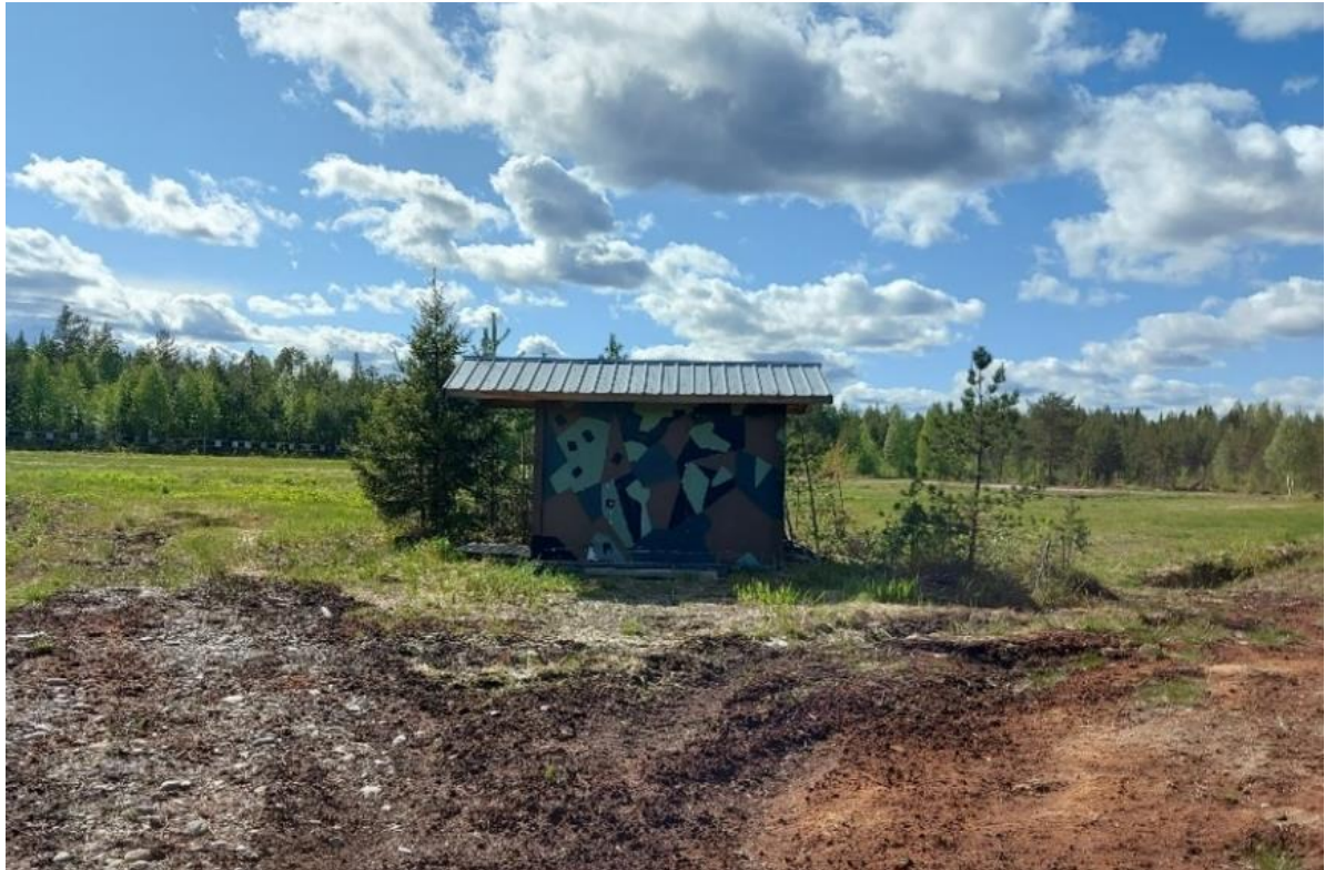
Kuva 6-5. Reitin 1 varrella sijaitseva hylätyn oloinen rakennus.
