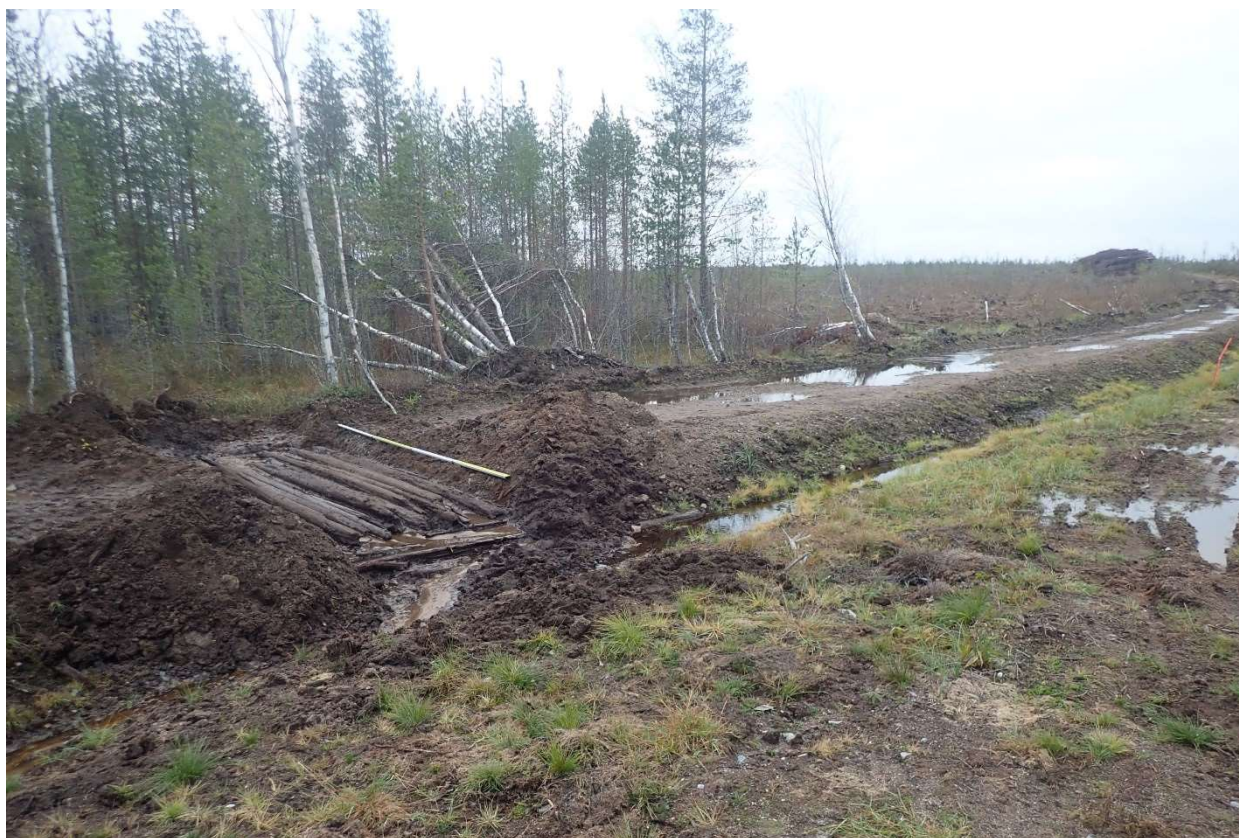
Kuva 14. Koejasta voidaan havaita tien poikkileikkaus. Puurakenteet jatkuvat tienpinnan alla tästä molempiin suuntiin. Luoteesta.
