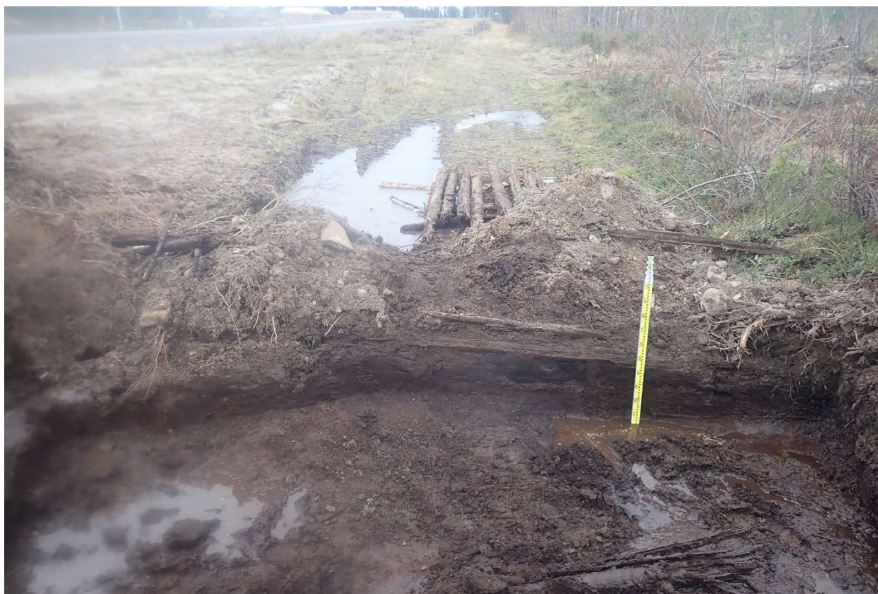
Kuva 21. Koeoja 3. Tien poikkileikkauksessa näkyy puurakenteita. Taustalla paikalta nostettuja puita.
