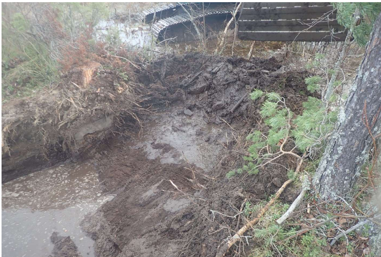
Kuva 4. Koeojan 3 itäreunan maakannasta kaivetaan. Muu osa koeojaa on jo pohjassa.
