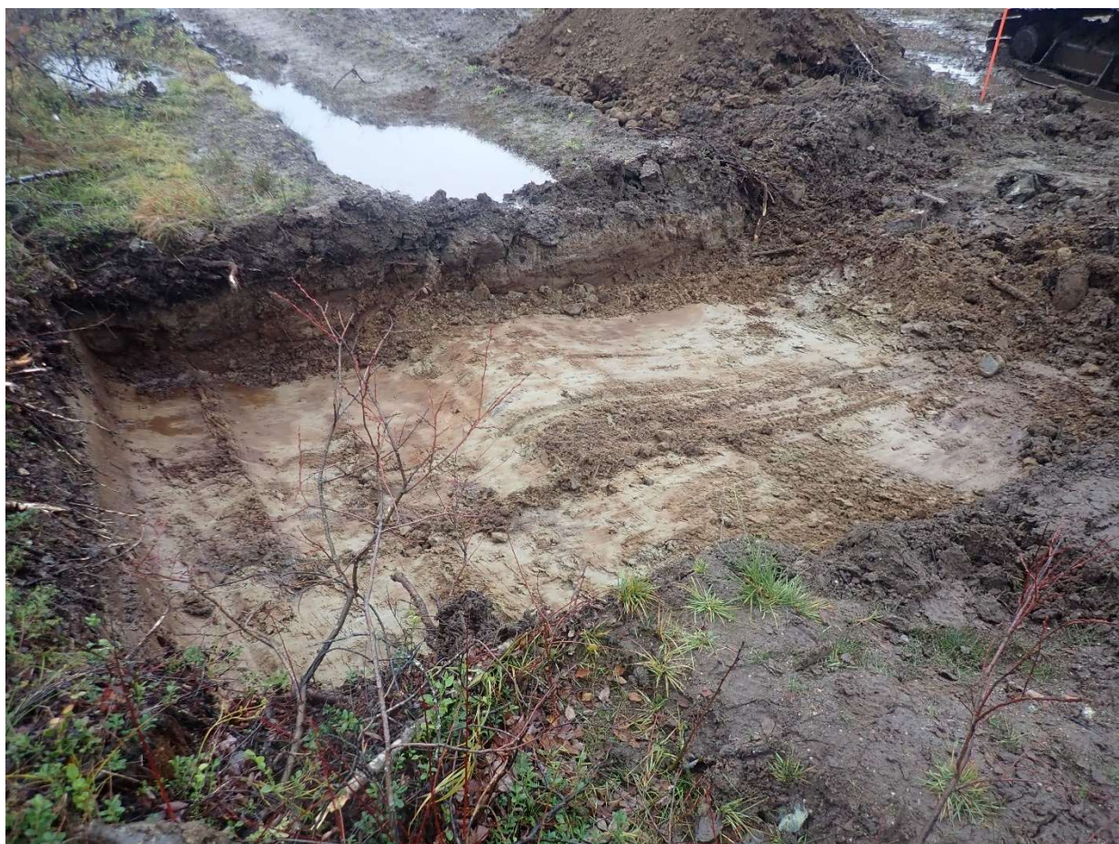
Kuva 8. Koeoja 1 pohjoisesta. Kaivannon pohjalla näkyy pohjahiekka. Taustalla kankaan puolella suokerros on hyvin ohut.
