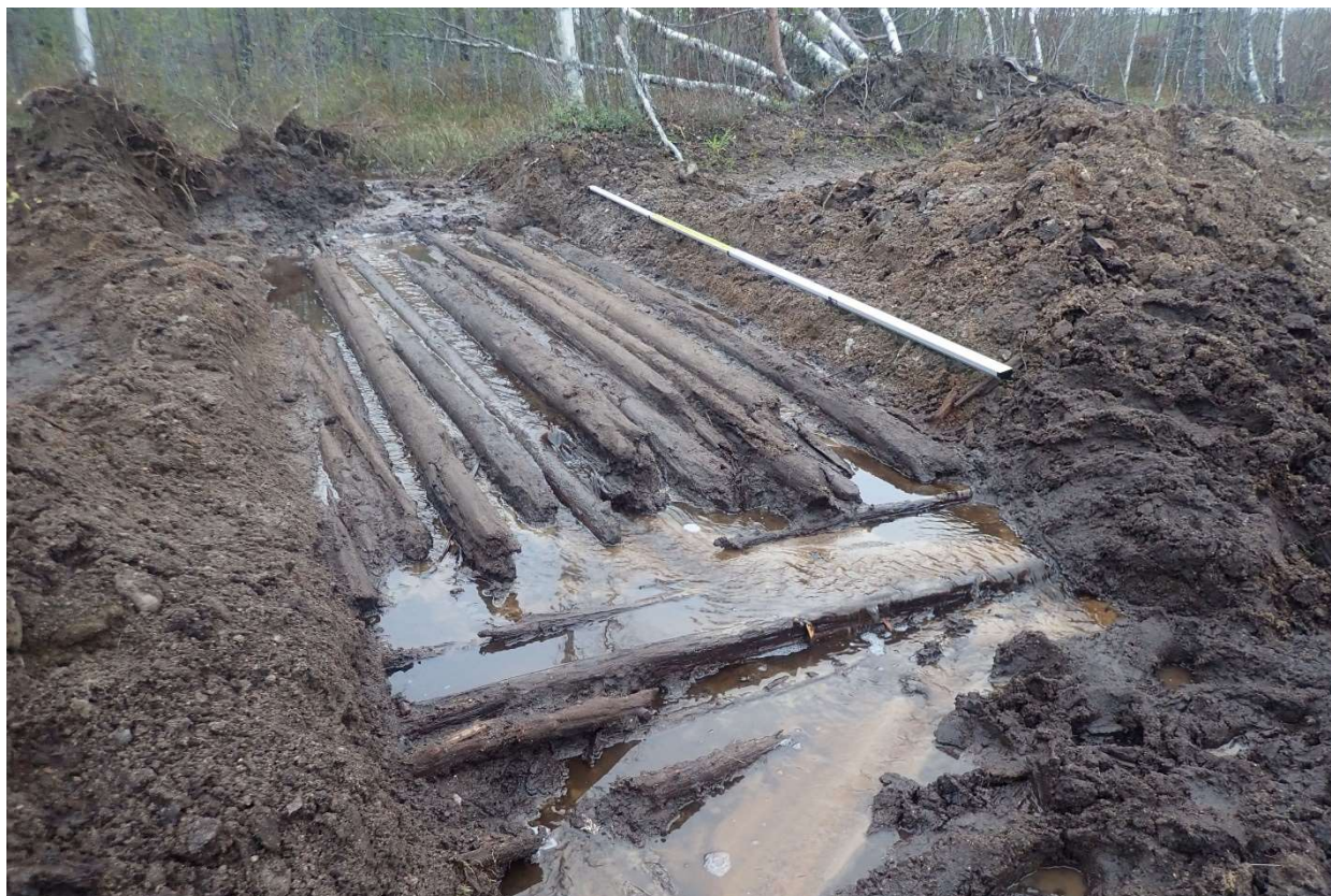
Kuva 13. Kapulasiltaa paikallaan luoteesta kuvattuna. Etualalla ohuita tiehen nähden pitkittäisiä runkoja. Tien keskiosa muodostuu suuremmista poikkirungoista. Luoteesta.
