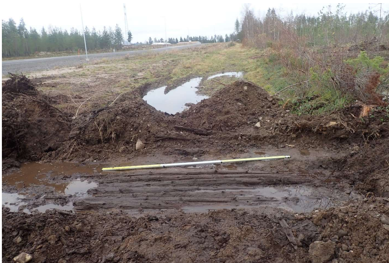
Kuva 20. Koeoja 3. Keisarintietä kohti pohjoista. Kapulasillan rakenne etualalla. Rakenne jatkuu molempiin suuntiin tien pintakerroksen alla.
