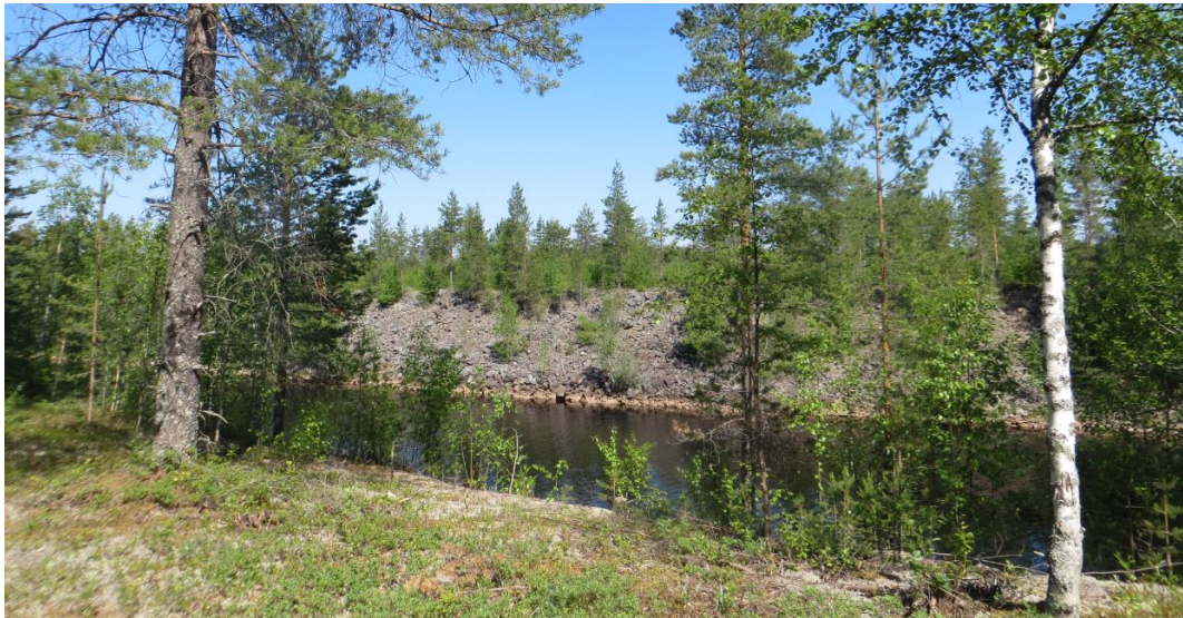
Kuva 6. Oulujokeen on kaivettu kanava Utajärven ja Sotkajärven välille.
