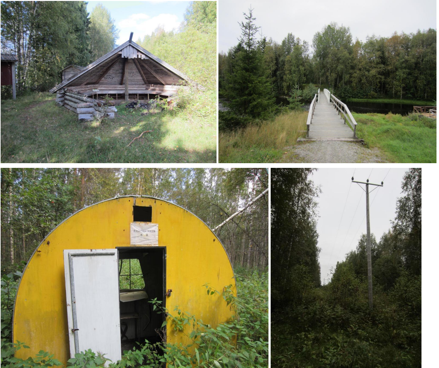
Kuva 14. Saaren rakenteita. Yläkuvat: laavu saaren eteläosassa. Saaren johtava kävelysilta. Alakuvat: sähkökaapelikelan koteloon on ”perustettu” Paskokosken Bar. Saaren poikki menee sähkölinja
