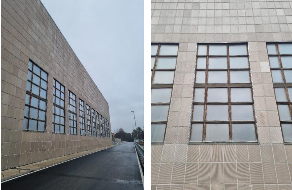
Kuvat 28 ja 29. Vuosina 1949–1954 rakennettu Pällin voimalaitosalue, jonka suunnitteli arkkitehti Arne Ervi, on valtakunnallisesti merkittävää rakennettua kulttuuriympäristöä.
