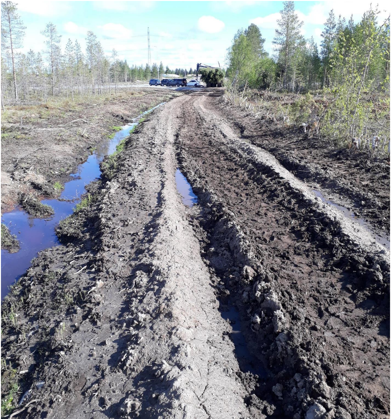
Kuva 11. Taustalla näkyvä ajokone on juuri ajanut tien kautta, mutta tämä tien osa on kantanut hyvin. Vieressä edellisvuosina kaivettu oja. Kuva: Arttu Tokoi.
