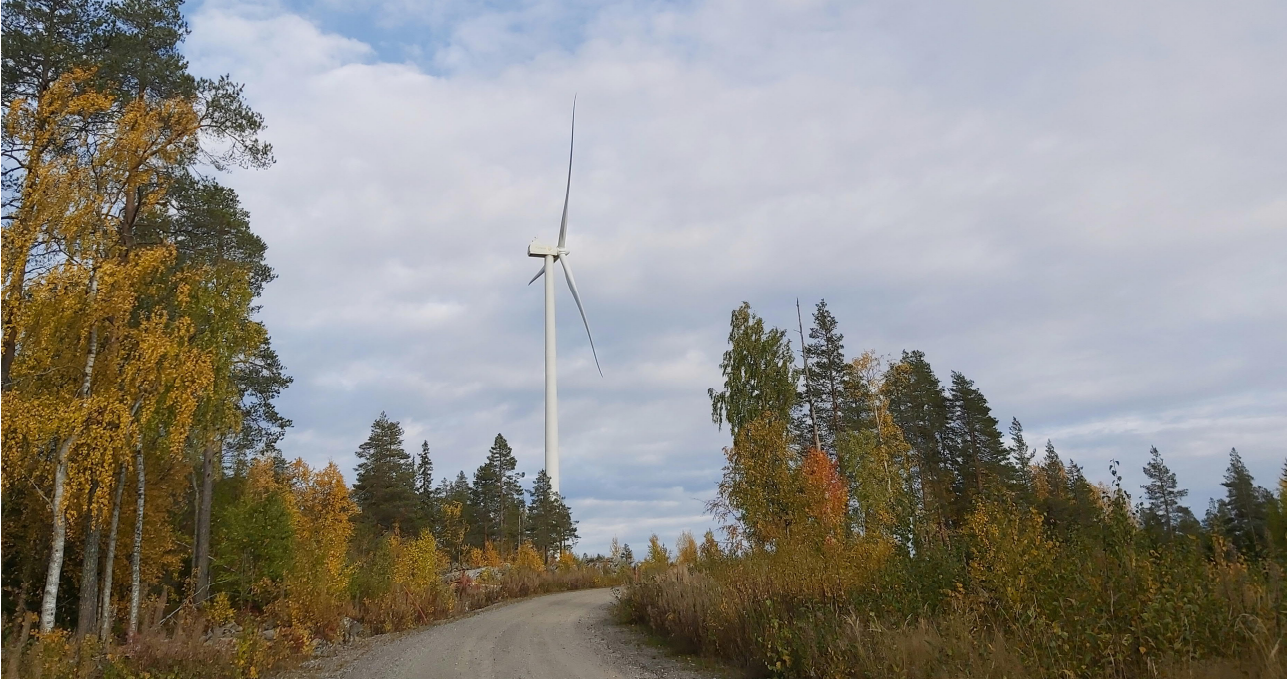
Kuva 43. Tuulivoimaloiden rakentaminen ja huoltotoimenpiteet edellyttävät tieverkkoa ja tilaa kunkin turbiinin ympärille.
