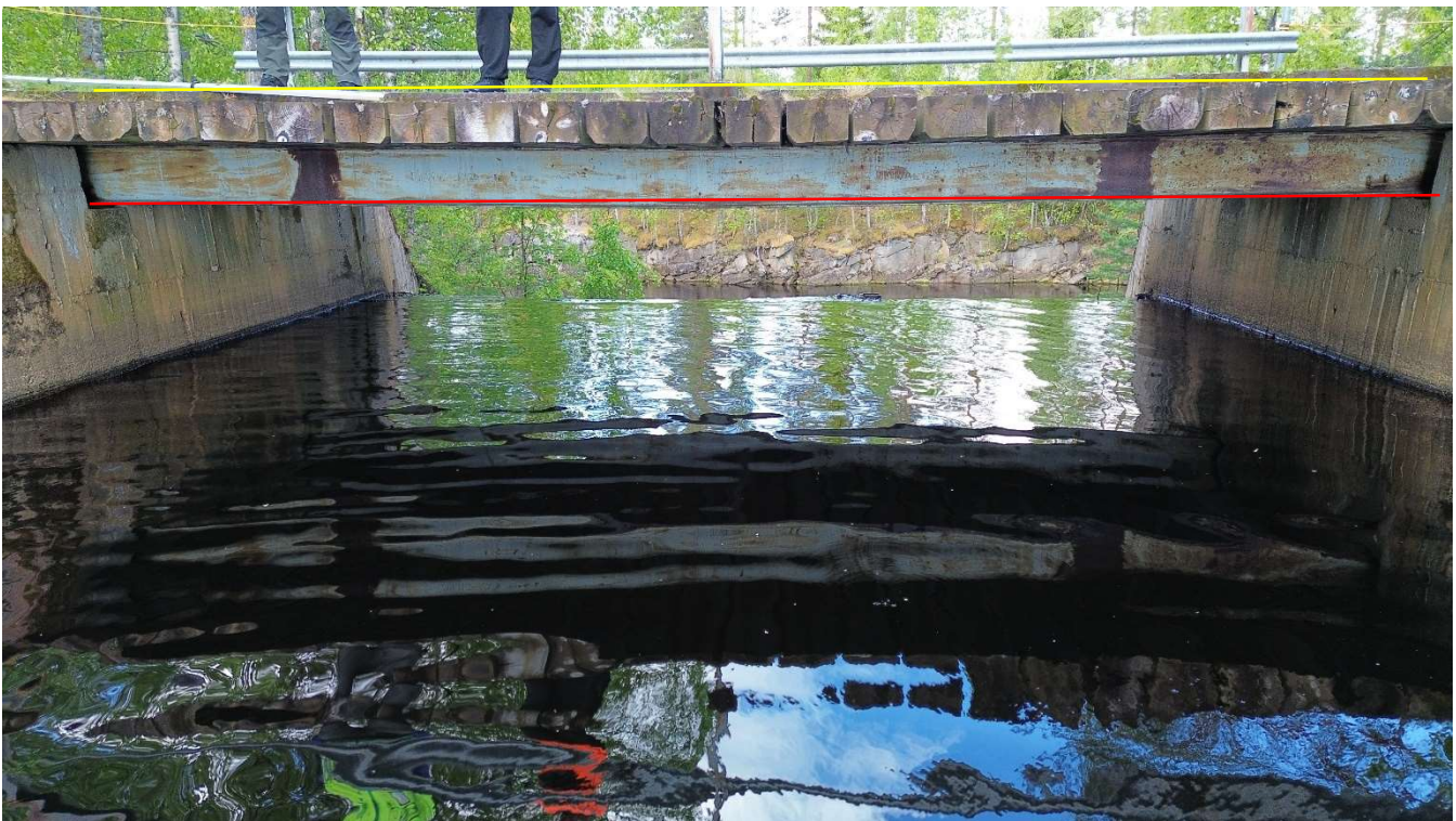
Kuva 10. Palkkien kantavuus ylitetty
